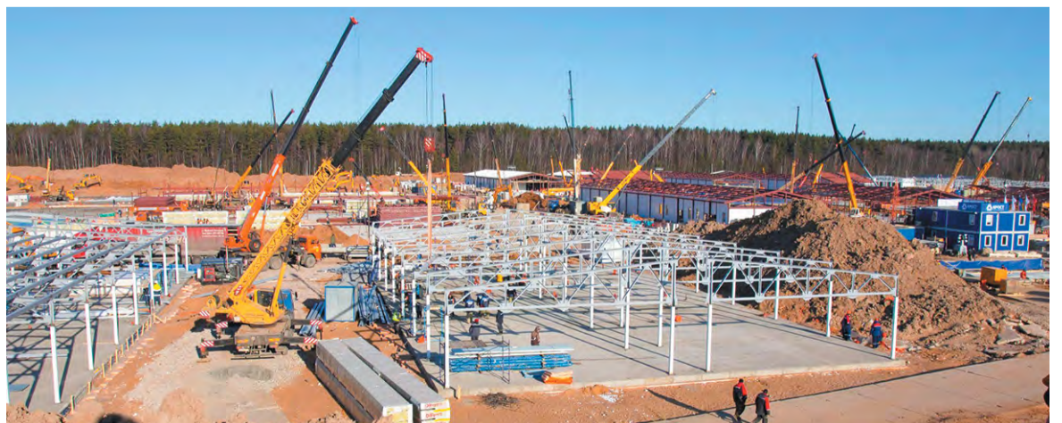
Строительство инфекционного комплекса в поселении Вороновское идёт полным ходом
